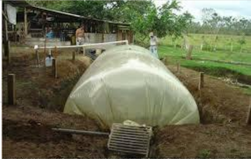
FIGURA 2. Biogestor en bolsa doble de polietileno de bajo costo, modelo Taiwán, recién instalado (aún sin techo, ni cerca periférica), operando en una finca familiar.
